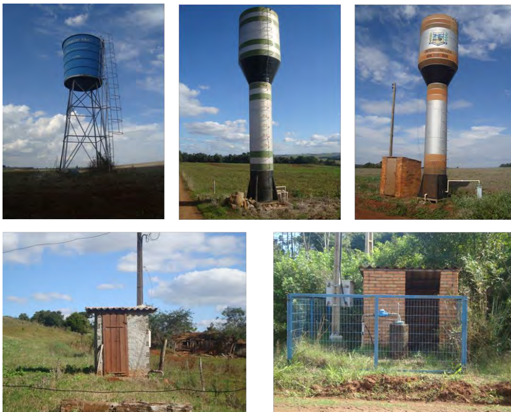
Figura 20 – Condições atuais do sistema de captação e tratamento de águas da área Rural
