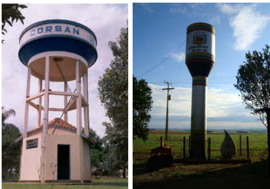
Figura 22 – Sistema de Reservação Urbano
