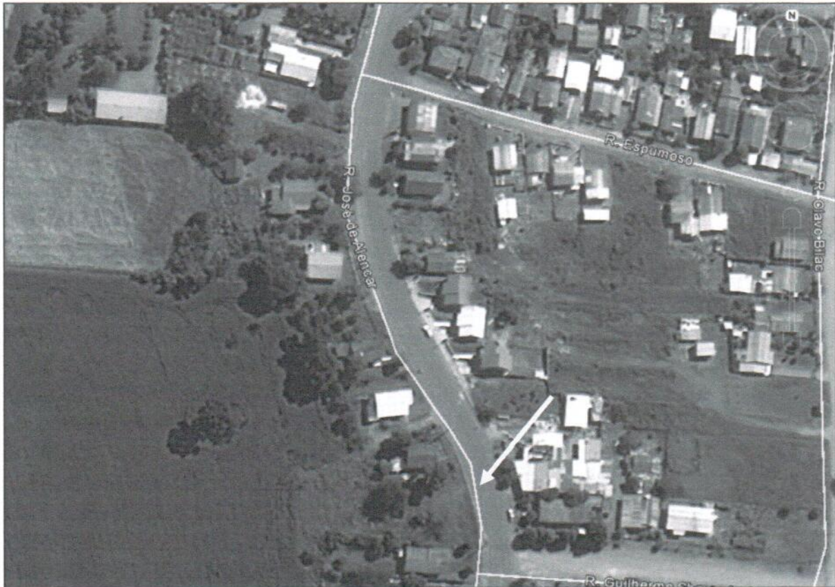
Foto 4: Local definido como ponto 14 , de instalação da Ondulação Transversal.
