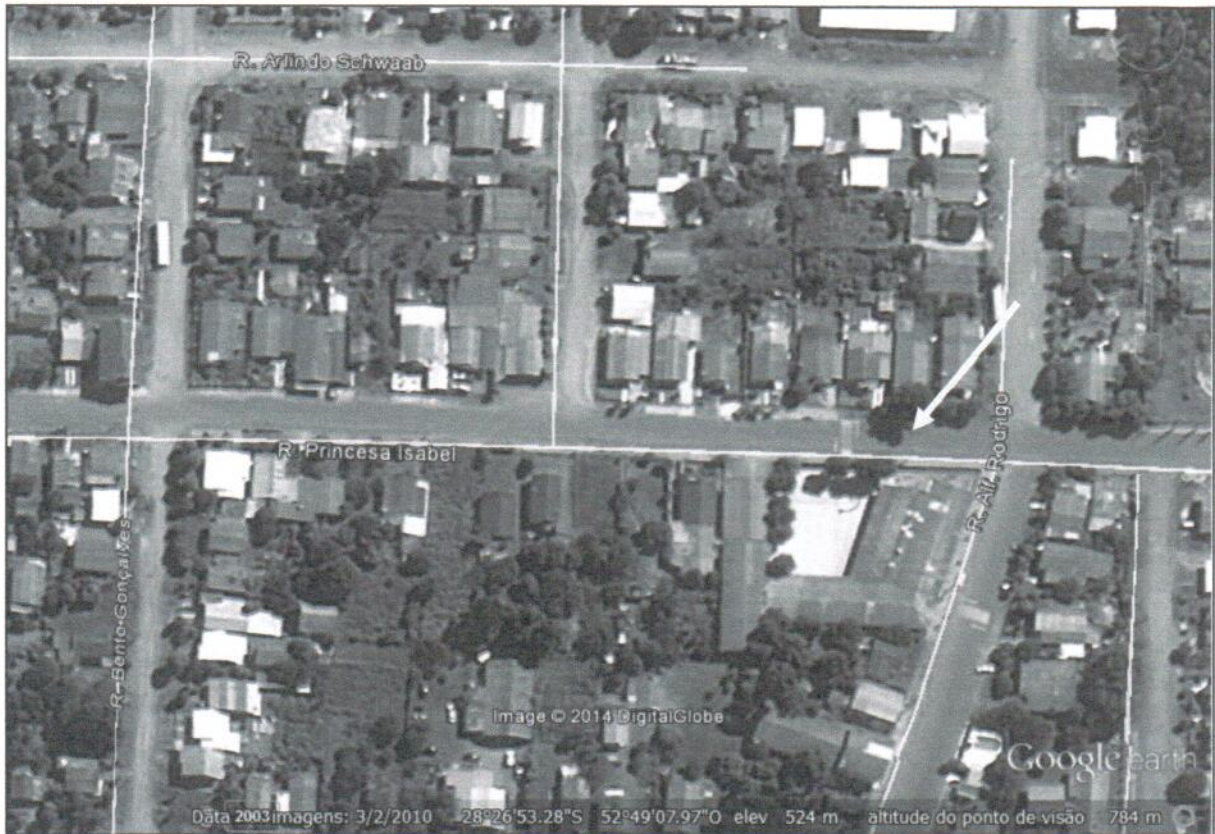
Foto 2: Local definido como ponto 12 , de instalação da Ondulação Transversal.
