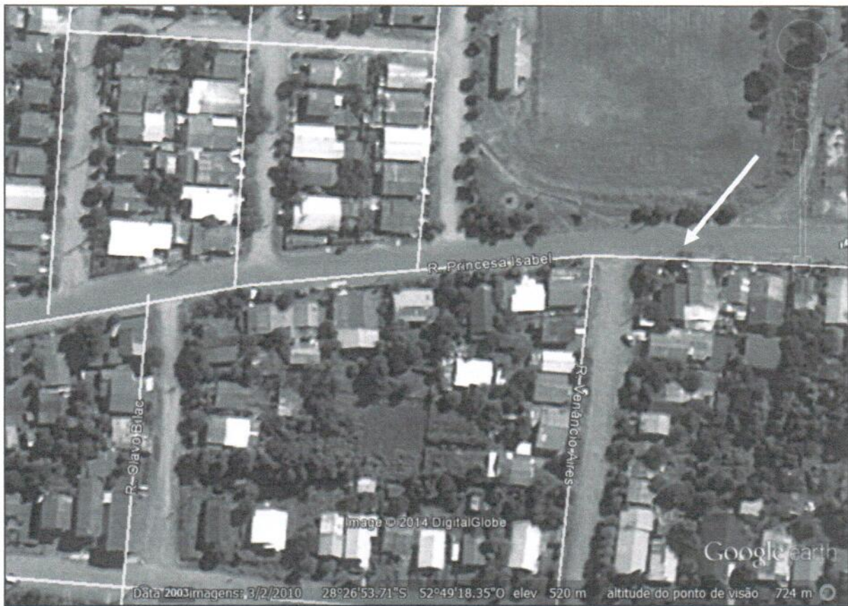
Foto 3: Local definido como ponto 13 , de instalação da Ondulação Transversal.
