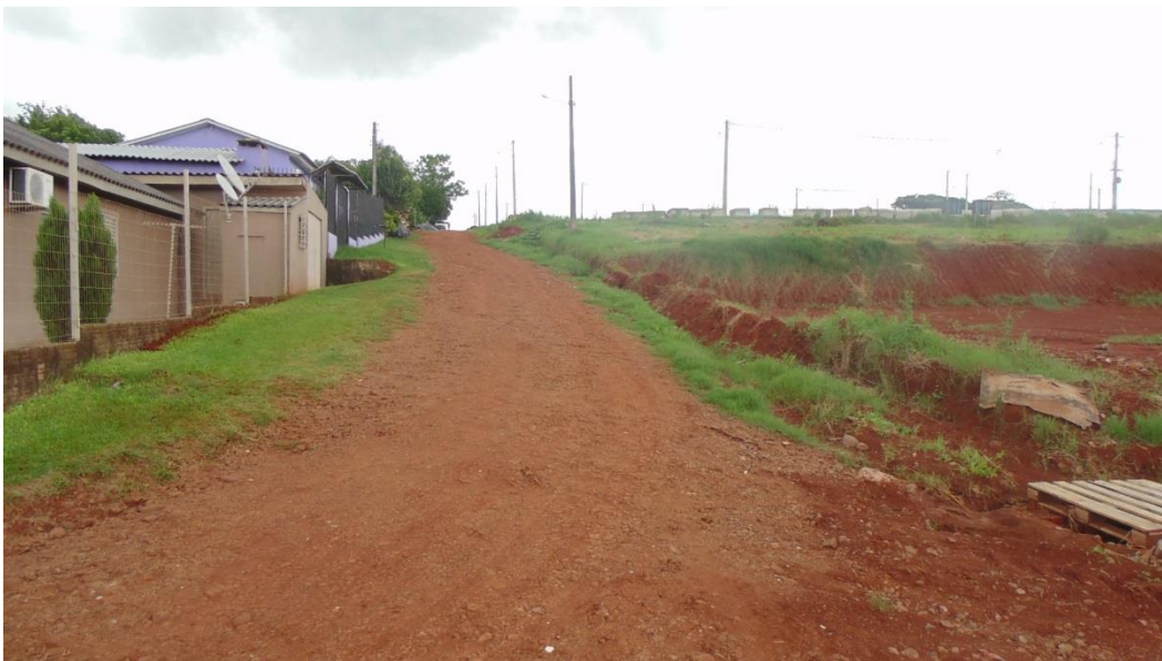
Foto 05: Rua Germano Griep, trecho entre Rua Ulisses Guimarães e Germano Bortolini. Passeios não executados, via com revestimento primário. Passeios 2m e pista de rolamento com 7,50m – pavimentação asfáltica.
