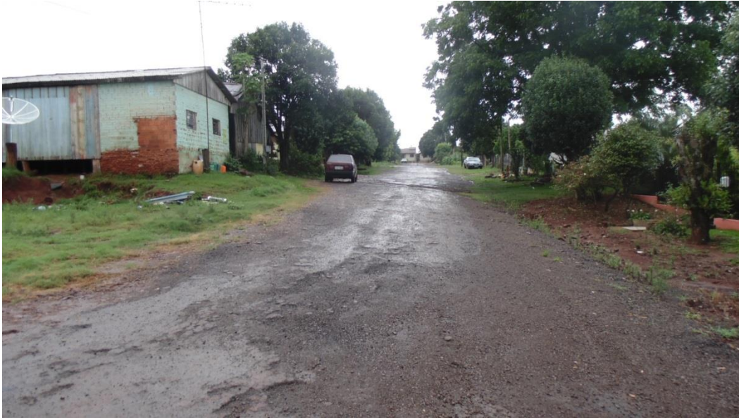
Foto 04: Rua Paraíba, trecho entre a Av. Belém e Rua Ceará. Passeios não executados, via com revestimento primário e resíduo asfáltico. Passeios 2,50m e pista de rolamento com 10m – pavimentação asfáltica.
