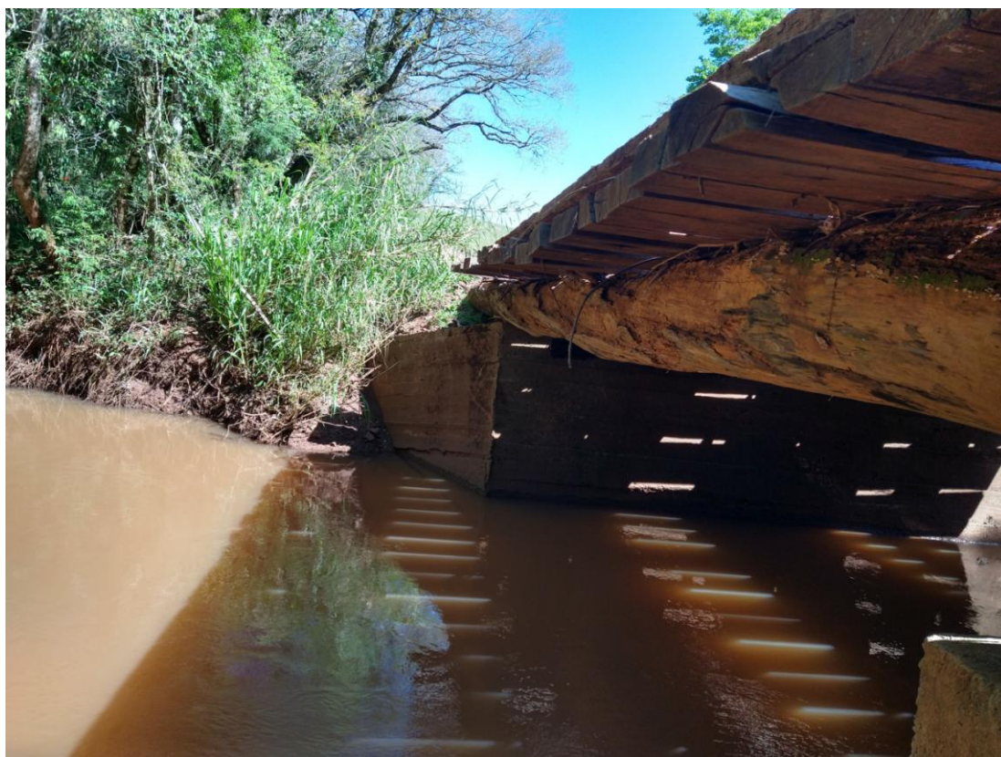
Cabeceira sul do leste para o oeste. Vistoria in loco 28/09/2023.
