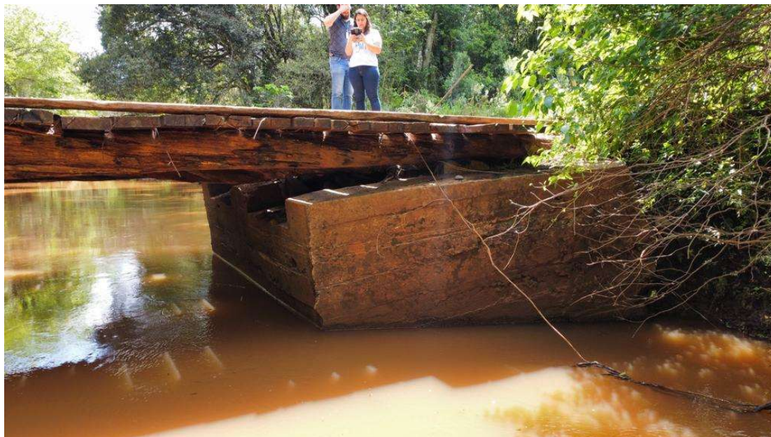
Cabeceira norte com drone no leste voltado para o noroeste. Vistoria in loco 29/09/2023.
