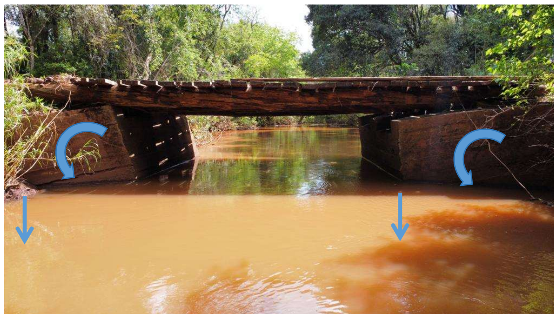
Drone no leste voltado para o oeste. Vistoria in loco 29/09/2023.
